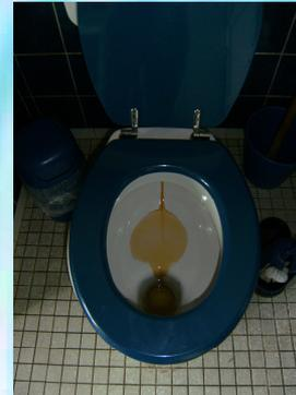
Eisen- und / oder Manganoxide führen zu Ablagerungen und Verfärbungen in den sanitären Einrichtungen.
