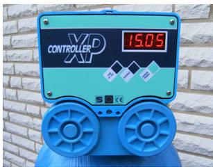
Diese **AquaBonita®**-Filteranlagen arbeiten vollautomatisch. D.h. das Rückspülen erfolgt ohne weitere Eingriffe zu den werkseitig programmierten Zeiten.
